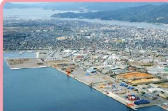
<昭和南岸壁国際コンテナターミナル>
